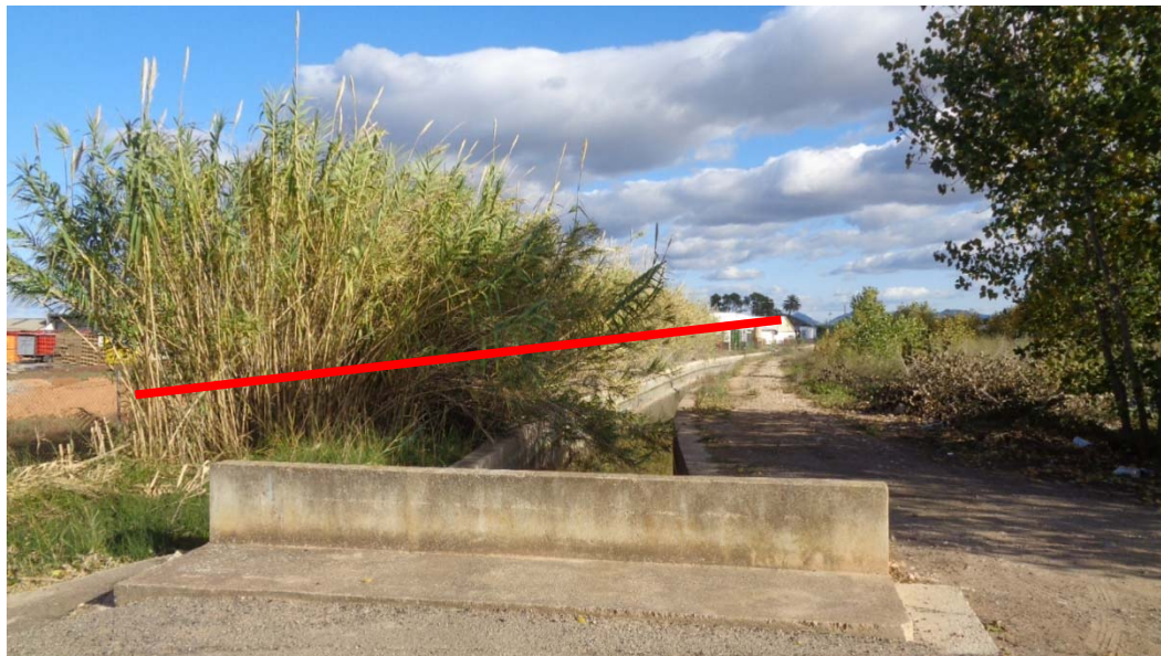
Fachada meridional, zona industrial consolidada separada de los huertos de frutales la zona de parking y la Acequia de Escalona
