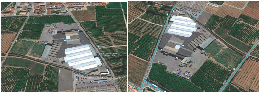
Vista aérea del ámbito de actuación.
