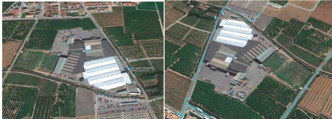
Vista aérea del ámbito de actuación.
