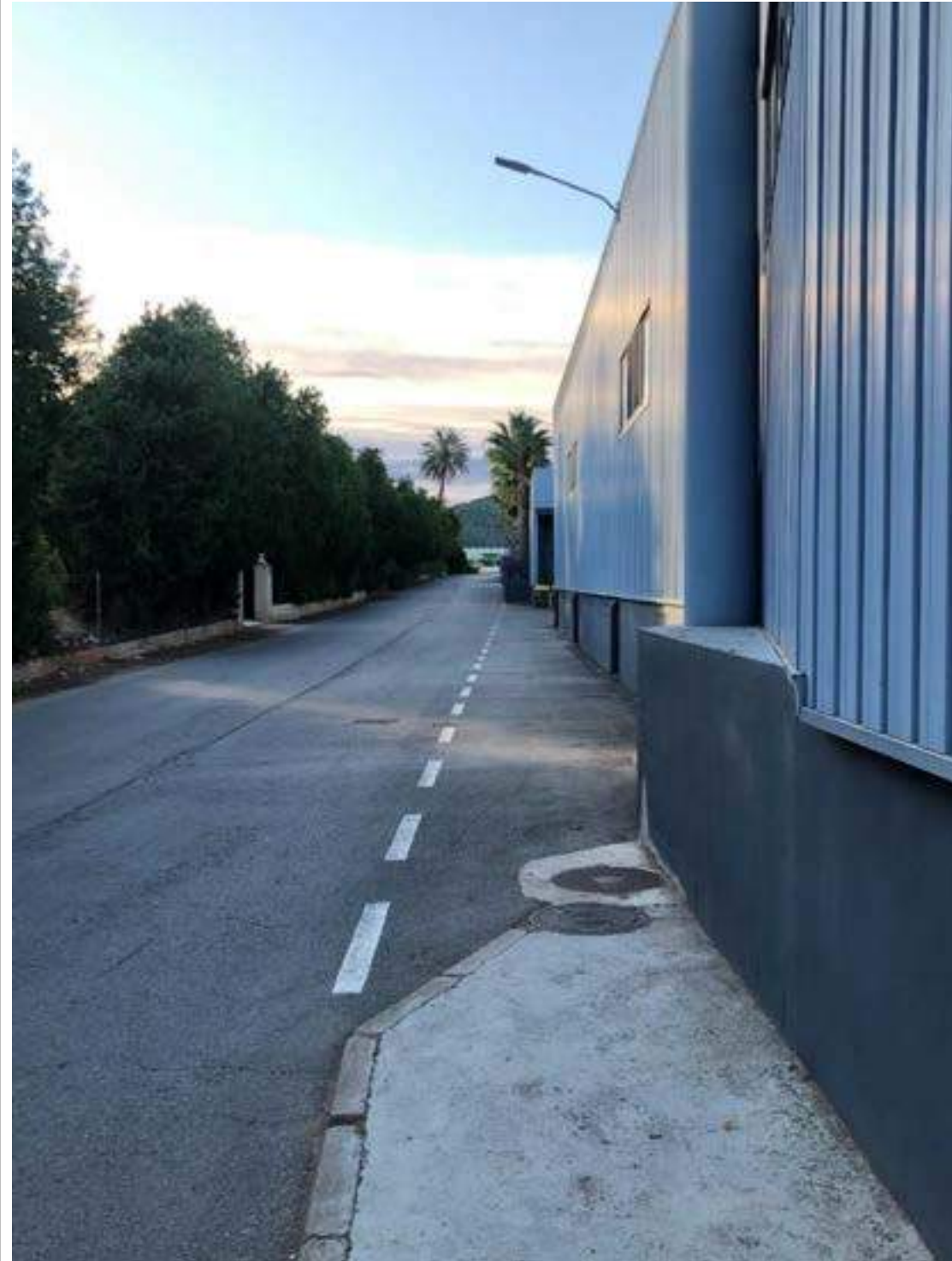
Vial Este. Estado acera existente
