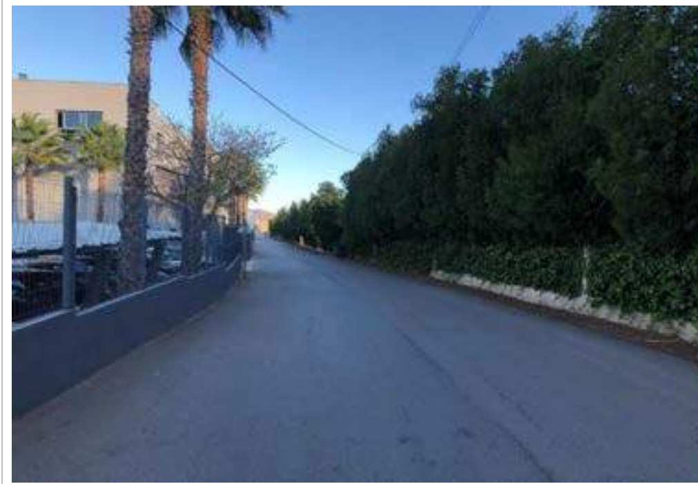
Vial Este. Vista general
