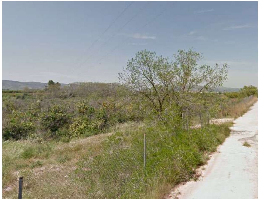
Ilustración 7 Línea eléctrica. Fuente: Google earth.
